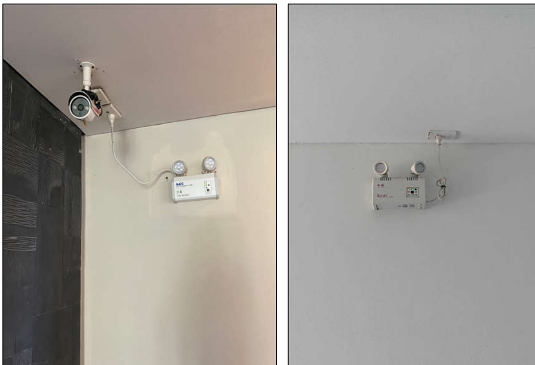
ภาพที่ 29 แสดงไฟส่องสว่างฉุกเฉิน
